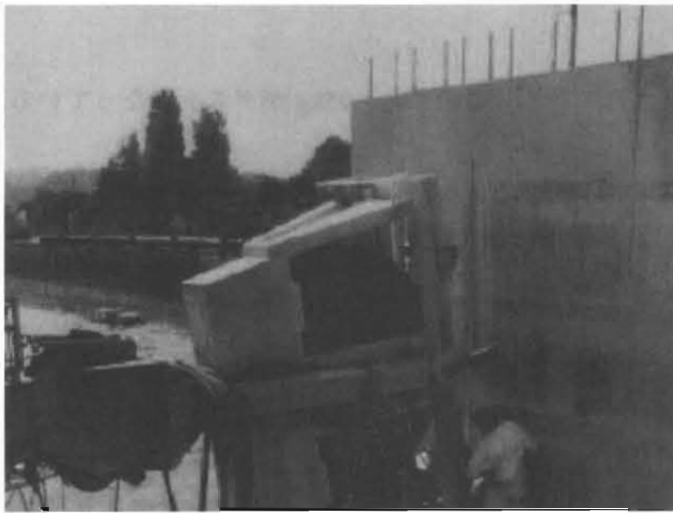
図7 生体遮へい壁解体用のサーキュラーソー
