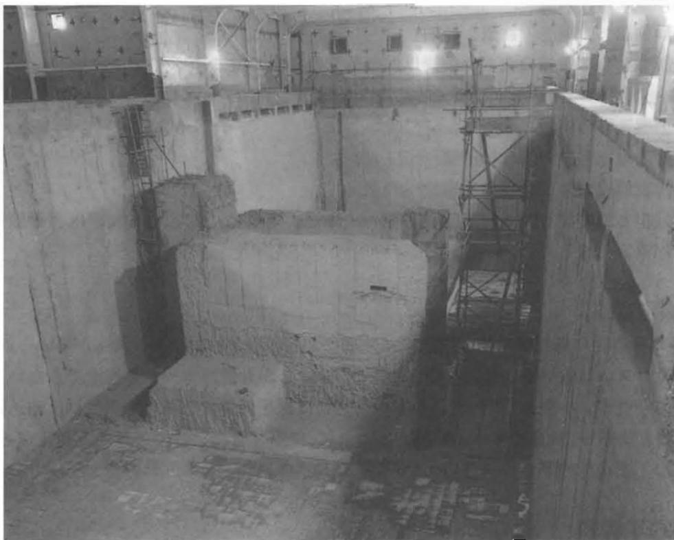
写真2 除染終了後の燃料貯蔵プール建屋内部
